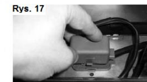
Rys. 17 Założyć i zapiąć skrzynki połączeń
